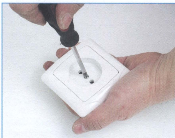
1 Снимаем наружную панель розетки — для этого откручиваем винт посередине. В некоторых розетках она отщелкивается.
