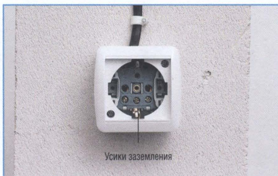
15 Поправляем усики заземления, если они погнулись.
