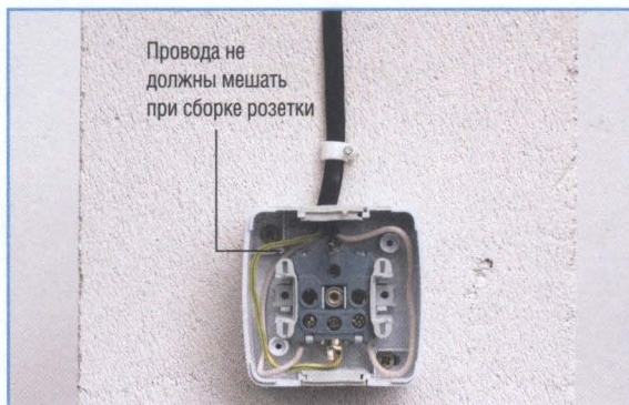
13 Устанавливаем механизм внутрь корпуса.
