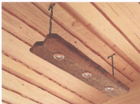
Крепление точечных светильников в декоративной планке
