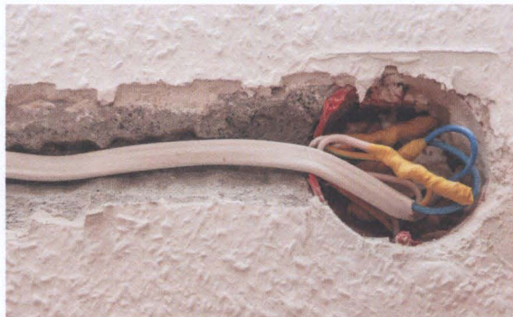
Установочная коробка и провода, уложенные в штробу
