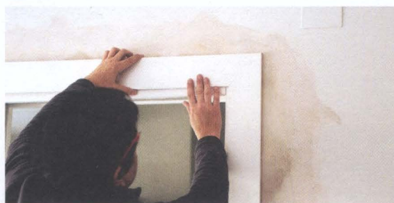
Современные модели дверей предполагают наличие канала под кабель, который эстетично скрыт под наличником
