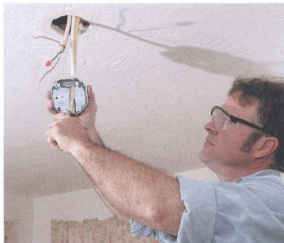
Монтаж коробки крепления под люстру в гипсокартонном потолке
