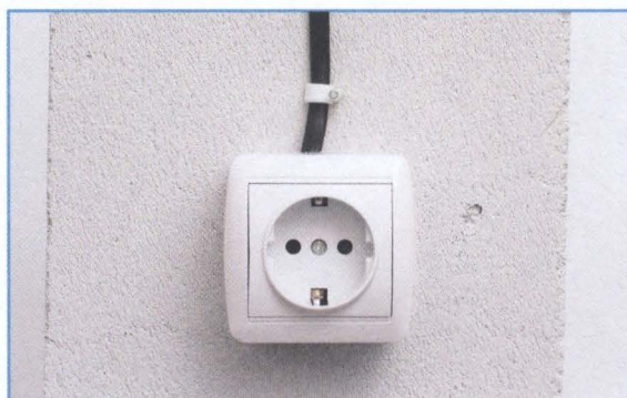
16 Ставим крышку на розетку.
