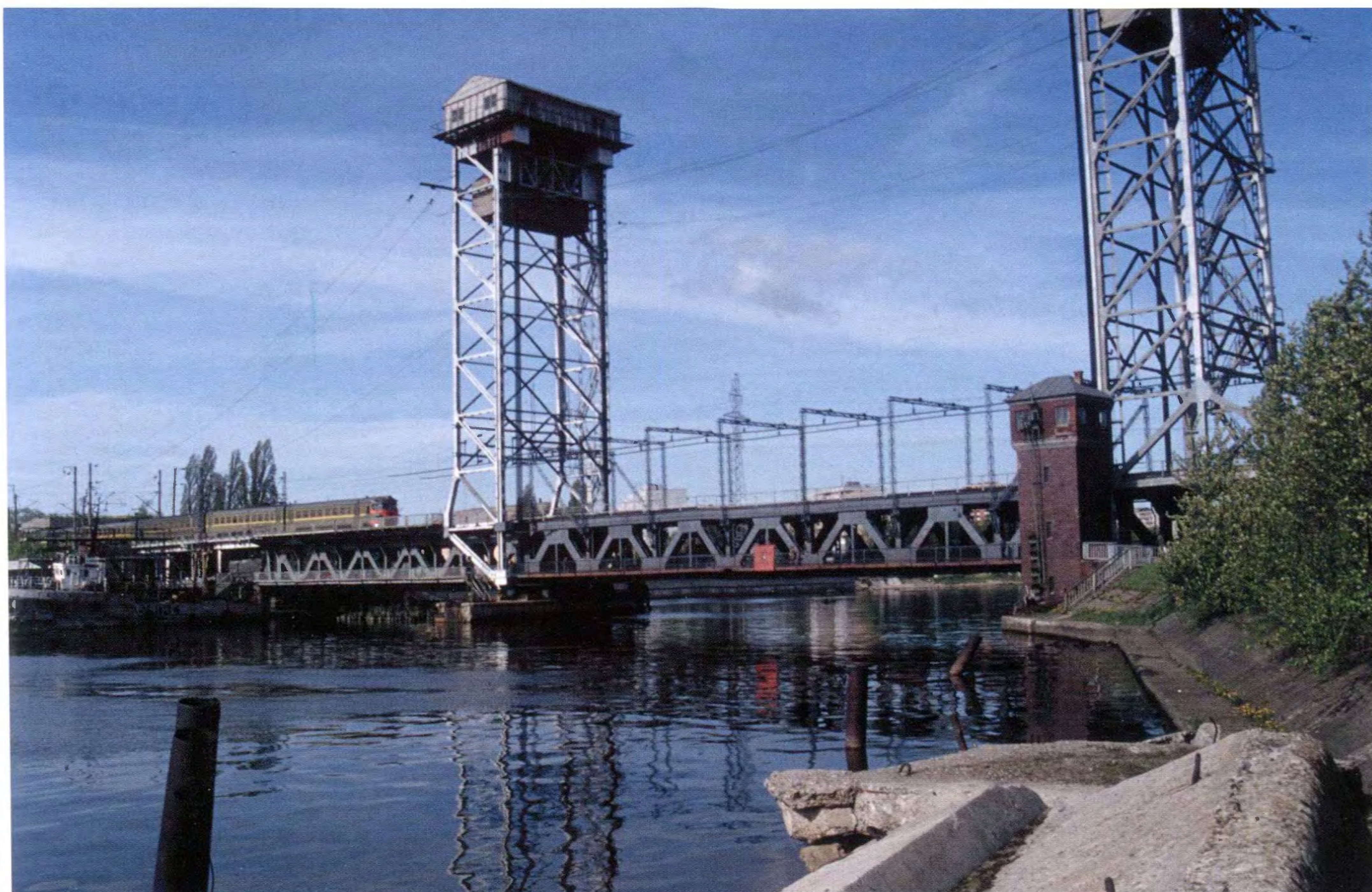
294 Вид с юго-запада на новый подъёмный мост (бывший Райхс- баннбрюкке) с новой подъёмной конструкцией (видны два больших противовеса); справа – южная башня (северная башня сегодня отсутствует)
