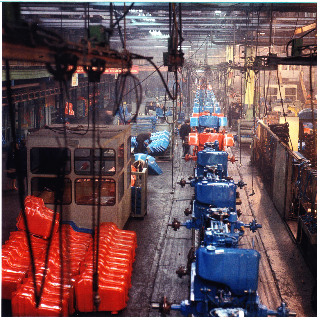
Конвейер сборки тракторов МТЗ-50 и МТЗ-52. 1972 г.
