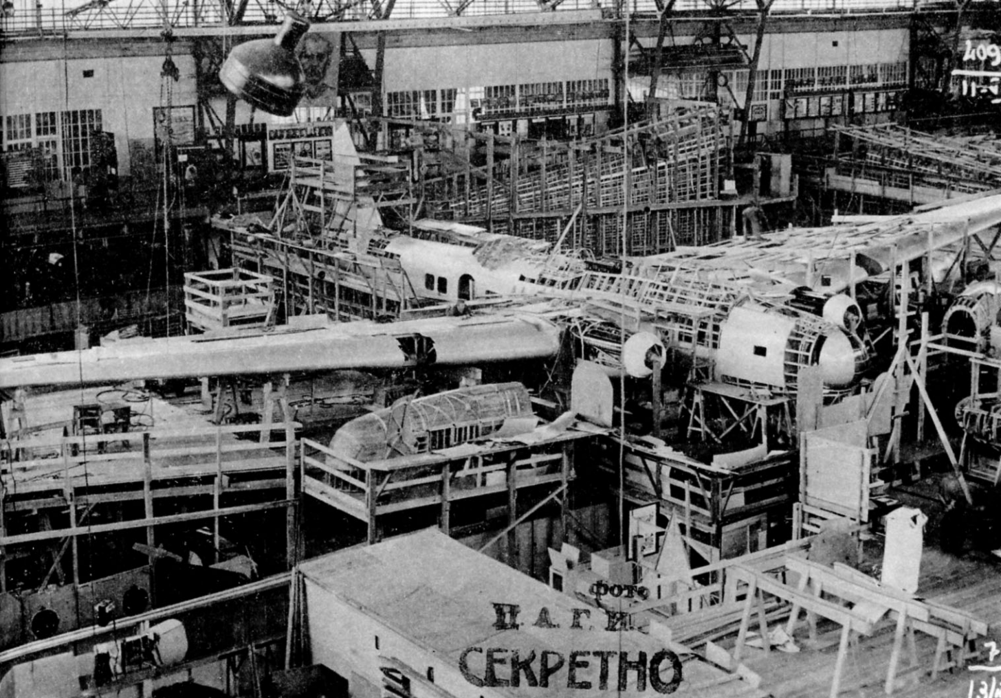
Сборочный цех Завода Опытных Конструкций (ЗОК) ЦАГИ 11 июня 1936 г. Сборка первого опытного АНТ-42 велась весьма решительно. По состоянию на 9—11 июня 1936 г. к фюзеляжу при- стыковали крылья, носо- вую часть и вертикальное оперение
