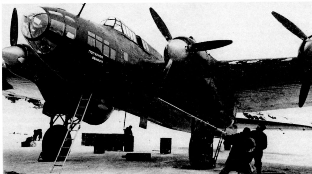
Проворачивание воздушного винта перед запуском двигателя на Пе-8 СССР-Н396
