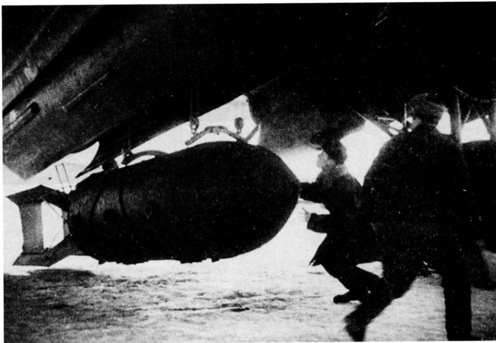
Подъем ФАБ-5000 с помощью лебедок в бомбоотсек Пе-8
