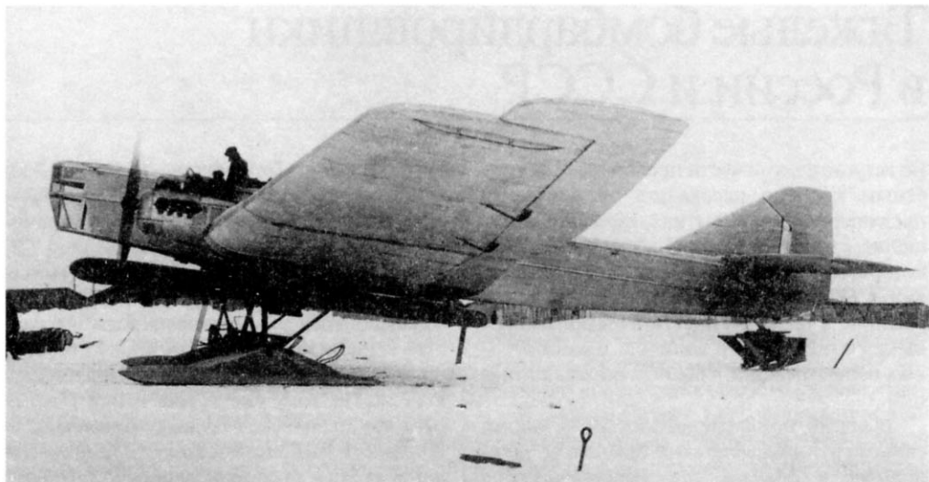
Опытный двухмоторный самолет АНТ-4 с подвешенным под фюзеляжем макетом морской торпеды. Зима 1925—1926 гг.
