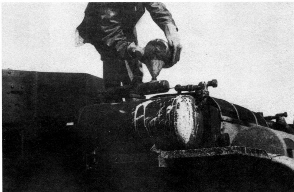
Заправка прибора ТДП-3 раствором для постановки дымовых завес. 1933 год (АСКМ).
