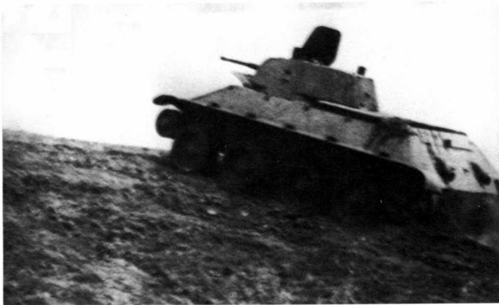
Танк А-20 во время испытаний преодолевает подъем на колесном ходу (АСКМ).
