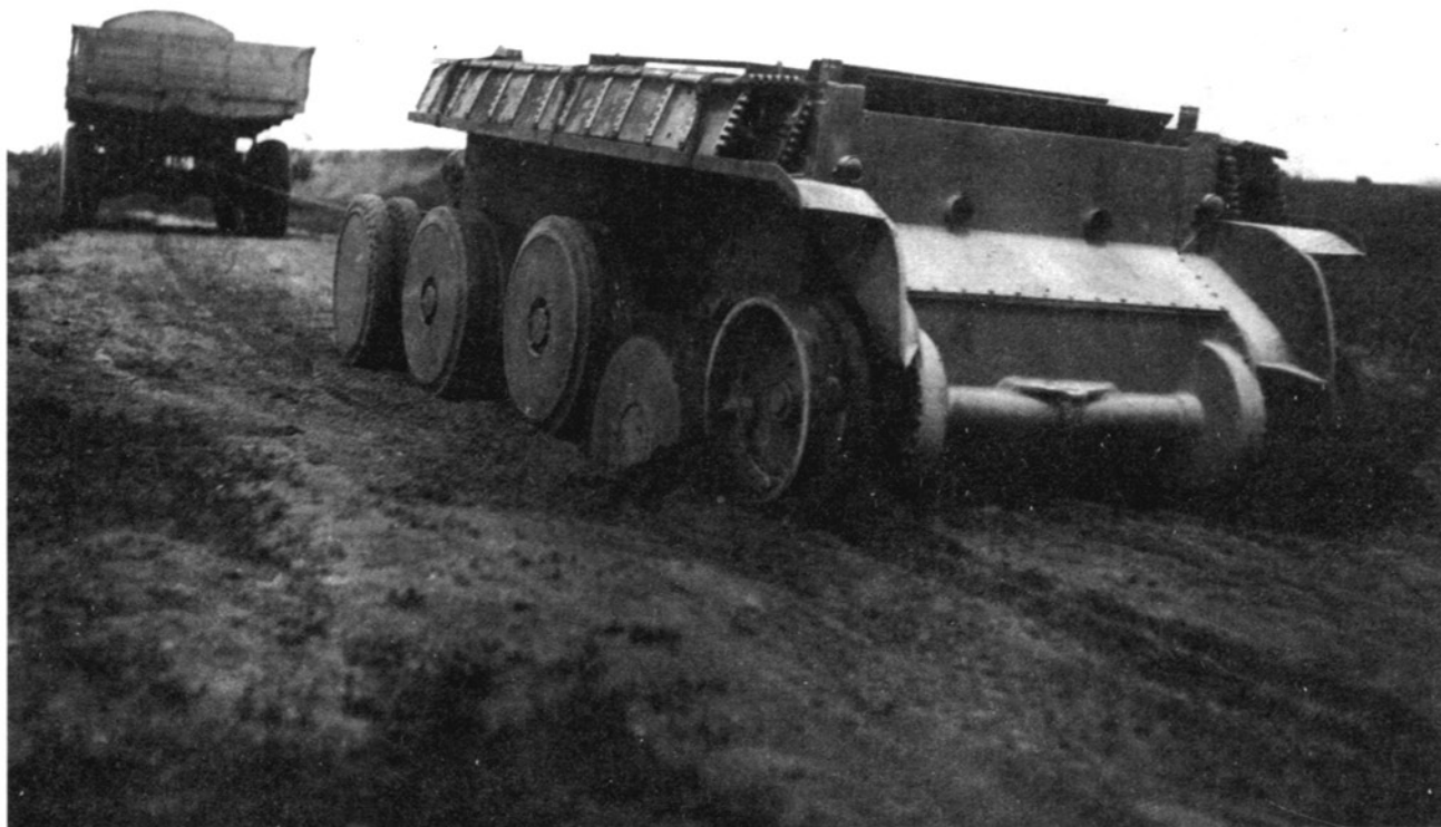
Буксировка застывшего на песчаной дороге танка Кристи М. 1931 при помощи английского тягача «Скаммел». НИИТ полигон, лето 1932 года (АСКМ).
