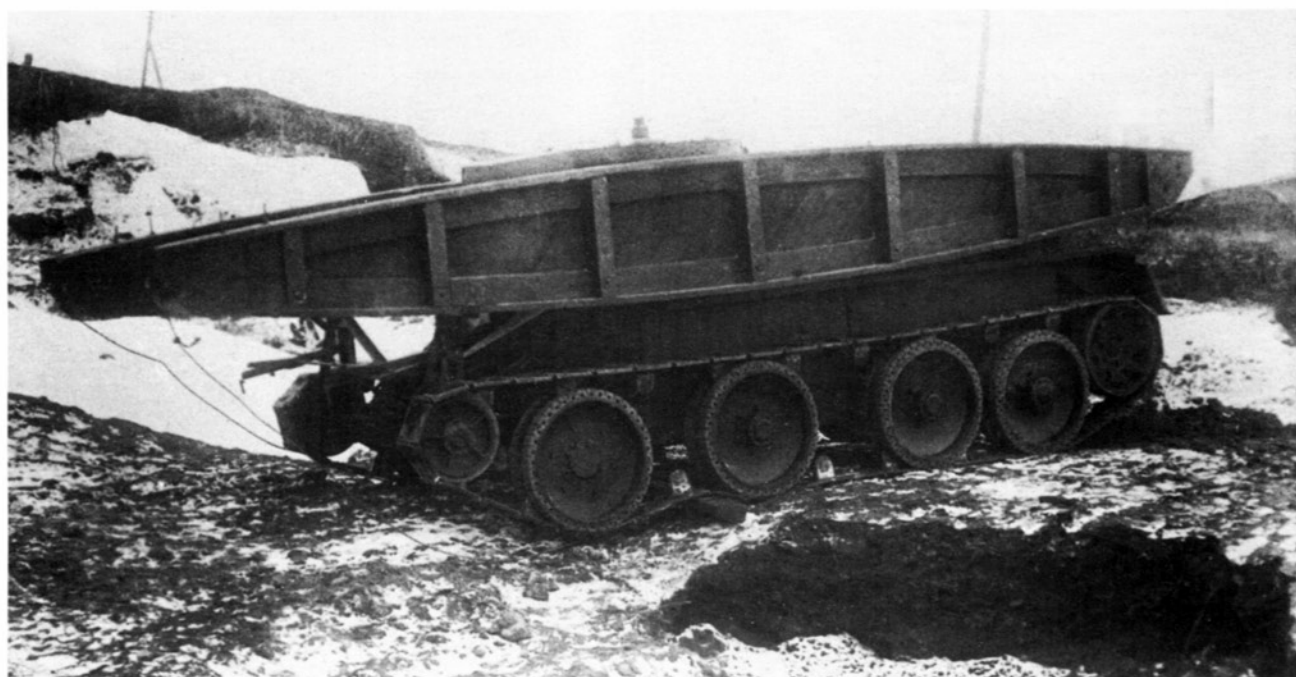
Танк БТ-5 с приспособлением для укладки деревянного моста конструкции НИИИТ РККА на испытаниях. Март 1935 года (АСКМ).
