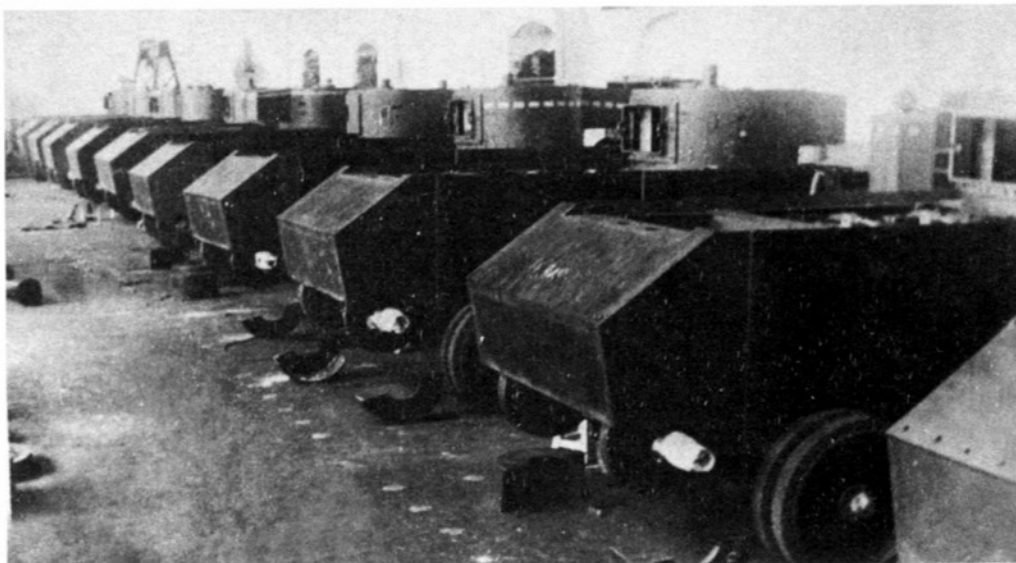
Сборка десяти танков БТ-ИС на базе БТ-5 на заводе № 48. 1936 год (АСКМ).
