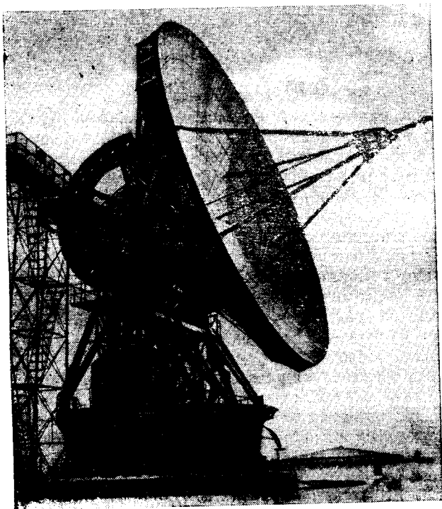
Рис. 96. Параболическая антенна радиотелескопа РТ-22 (диаметр 22 м) Горьковского института радиофизики.
